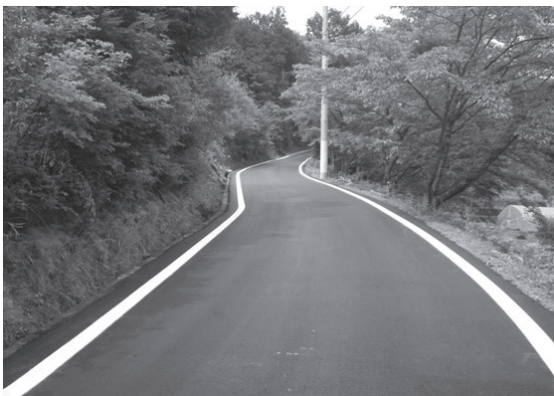
～繰越事業の社会資本整備総合交付金事業により路面修繕された、越原黒淵地内の村道泓線～
