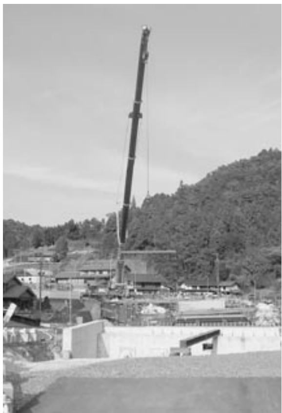
完成間近の長瀬バイパス(白川橋)
