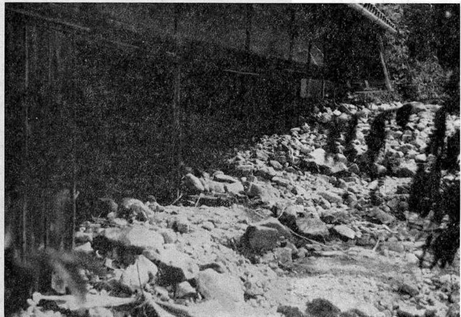
濁流とともに押し流された土砂に埋れた民家
