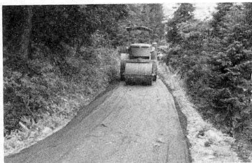
↑ 急ピッチで進んだ舗装事業
