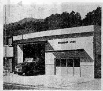
↑ 新築された第1分団詰所
