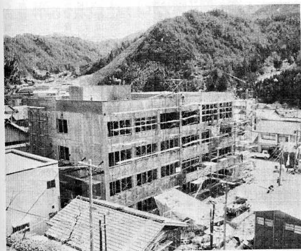
↑ 村の総合拠点ともなる山村開発センターの完成はもうすぐです。 現在内装工事が急ピッチで進められています
