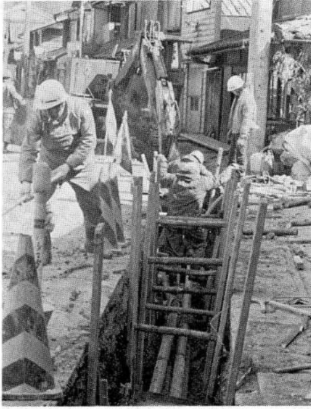
▲ 電話線の埋設作業 (平商店街で)
