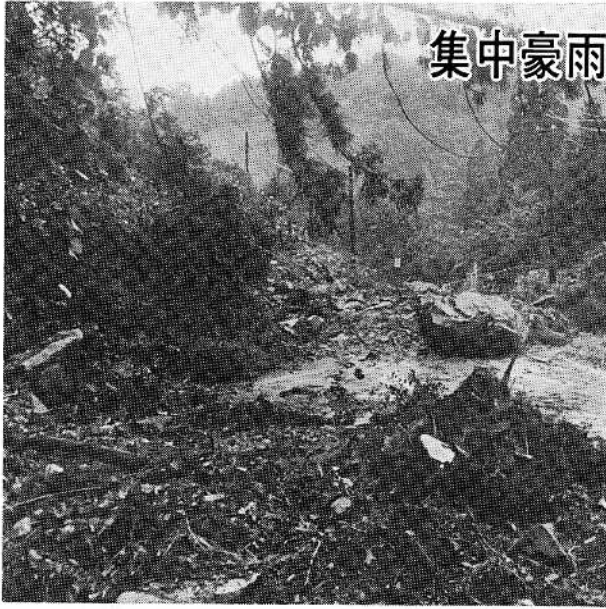
△ 8. 17災害一五加切貫付近の県道へ土砂崩れ一
