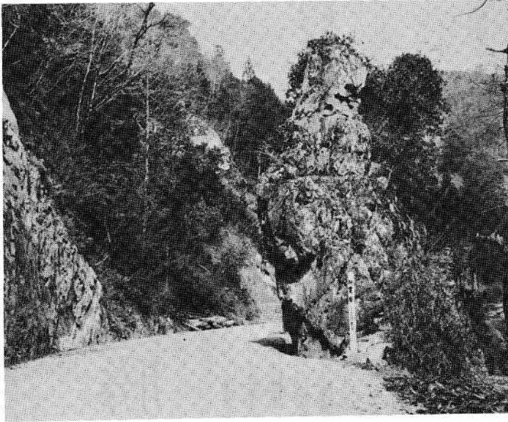
当時の苦闘がしのばれる柏本の切り貫し。現在はロックフェンスが張りめぐらされています（写真は昭和初期のもの）
