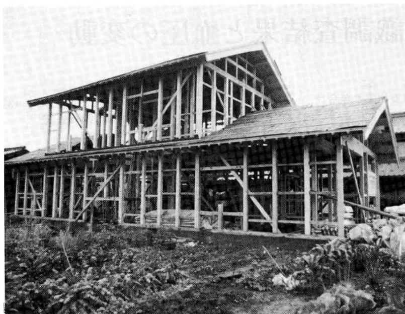
村内の業者が建築中の木造住宅
