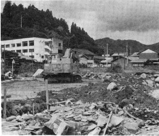
工事が始まった園舎の敷地
