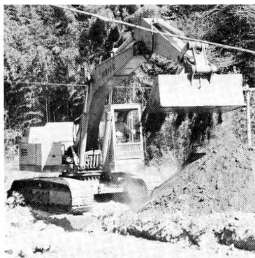
▲工事が始まった柏本地内
