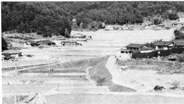
▲工事が完了した大明神地内
