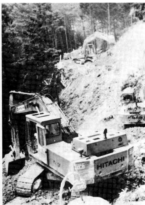
着々と進む林道開設工事（栃山地区内）
