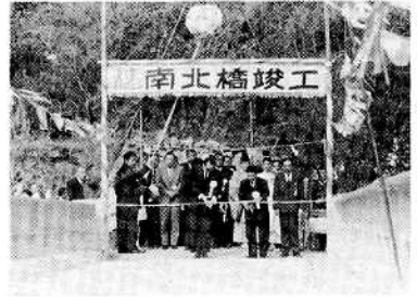
昭和45年2月念願の永久橋 南北橋が完成
