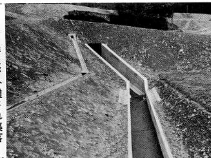
用水と排水が分離され集落の環境がよくなりました（黒淵地内）
