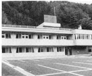
全面改築され生まれ変わった病棟
