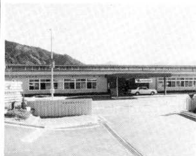
越原曲坂地内に完成した本社工場
