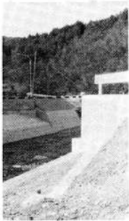
新・旧道路直結西洞橋梁工事
