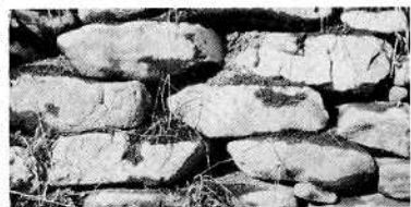
高遠石工の横積み（平高橋下）
