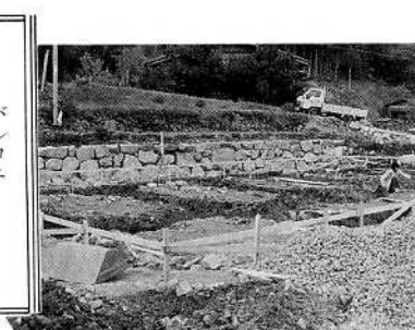
集合住宅建設現場
