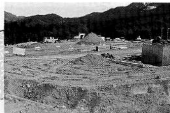
「総合グランド造成工事」 バックネット方向から望む
