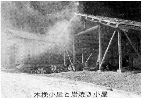
木挽小屋と炭焼き小屋
