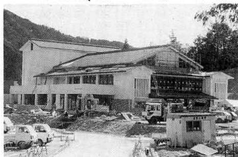
完成真近かのはなのき会館
