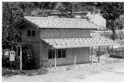
板屋根、(瀬音公園水車小屋)
