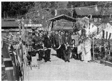
昭和30～40年代は、永久橋が続々完成。写真は36年、高橋の竣工。
