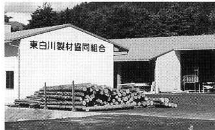
完成した東白川製材協同組合製材工場
