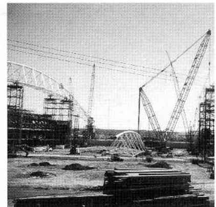
2000年に開催されるシドニーオリンピックの建設現場
