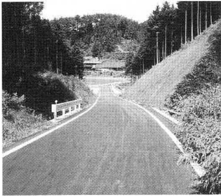
▲開設された黒淵線（黒淵地内）
