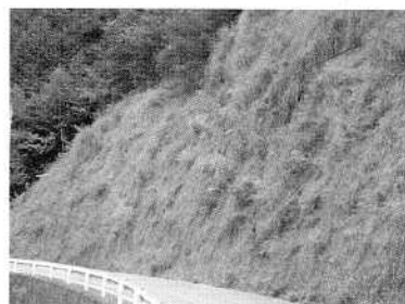
■神土角領線崩落決壊防止工事〈西洞〉 ■事業費：16,545 千円
