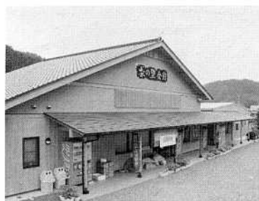
■総合交流ターミナル建設工事（茶の里会館）〈陰地〉 ■事業費：182,805千円
