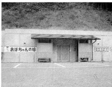
■農林水産物処理加工施設（白川茶屋）工事〈下野〉 ■事業費：29,478千円
