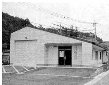
■コミュニティ防災センター建設工事〈陰地〉 ■事業費：19,219千円
