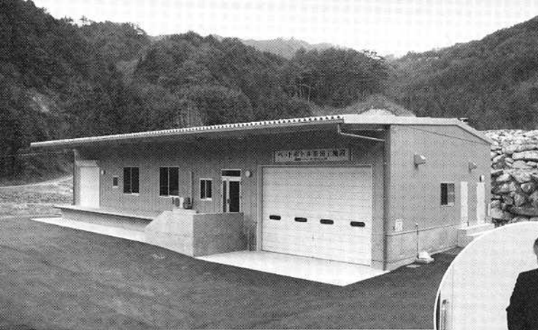
▲4月に竣工したペットボトル茶加工施設は、鉄骨平屋建246㎡。500ml入りのペットボトル茶を1日最大1,800本製造でき、年間30万本の出荷を計画しています。
