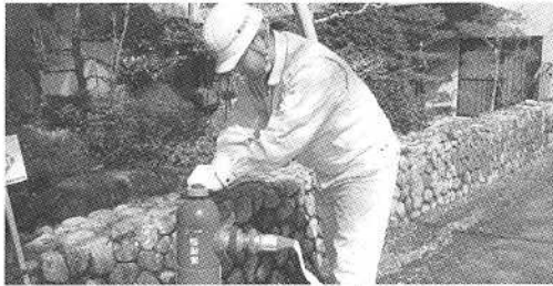
■消火栓操作者は、開閉器でゆっくり開栓し水を送る
