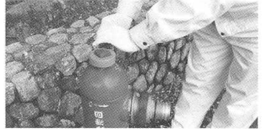
■消火栓の頭に開閉器を取り付ける
