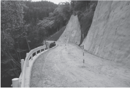
完成した林道尾城山線
