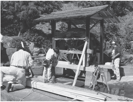
小学校での作業の様子
