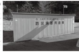
◎防災センター横の防災倉庫 村内の避難所18ヶ所に木造の防災倉庫を新設します。
