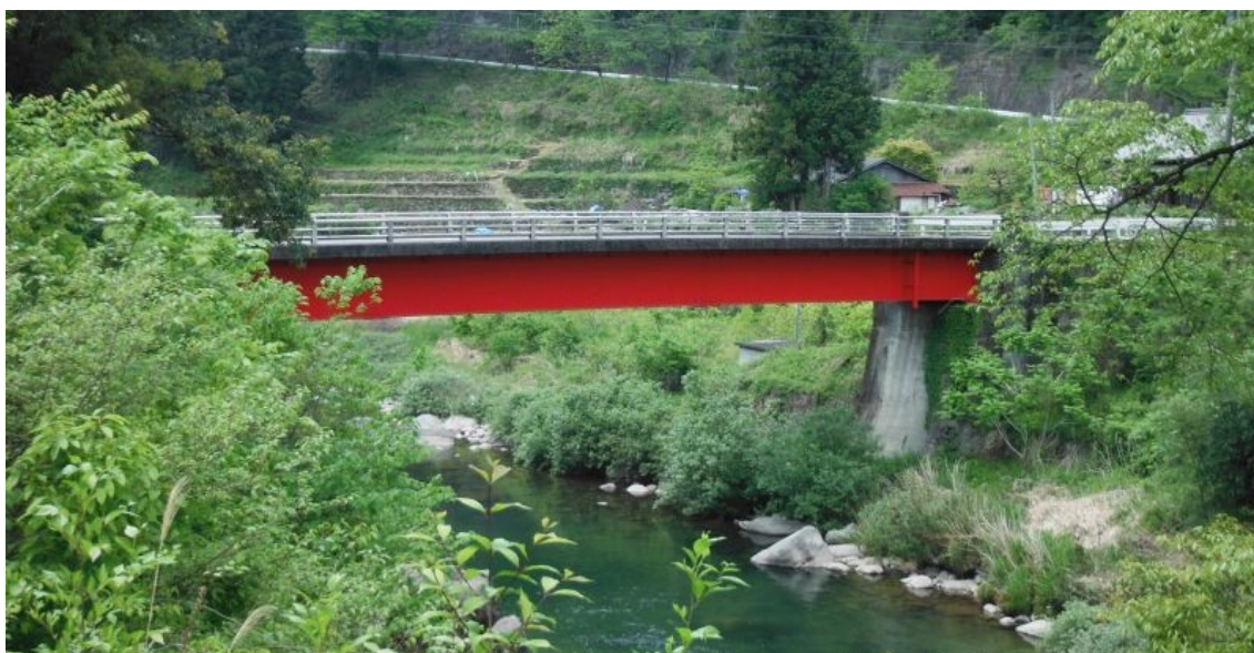
平成 24 年度 越原（陰地・曲坂） 越原橋
