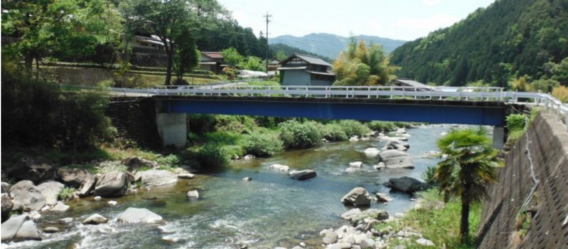
平成 25 年度 越原（陰地・曲坂） 岩倉橋
