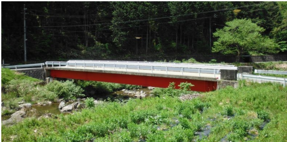
平成 23 年度 越原（栃山） 栃山橋
