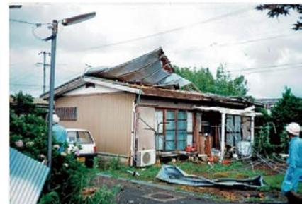
図117 トタン屋根の被害
