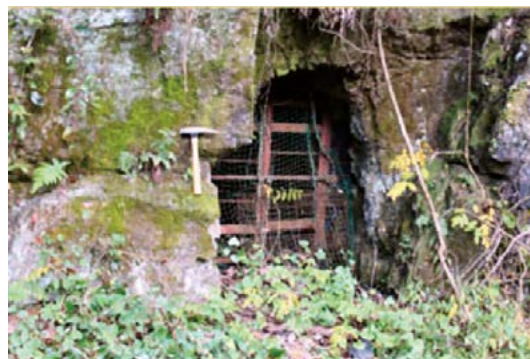
図66 掘削坑口の跡地
