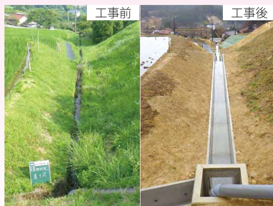
改修工事した水路（神付地内）
