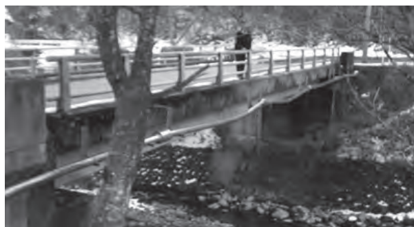
氏神橋水管修繕工事 写真
