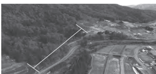
交通安全対策(通学路緊急対策)事業 木屋下線道路改良工事 計画位置図
